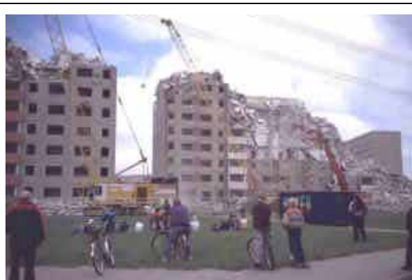
Foto 9: Erste Gebäudeabrisse "Pilotprojekt Rohrweg"
