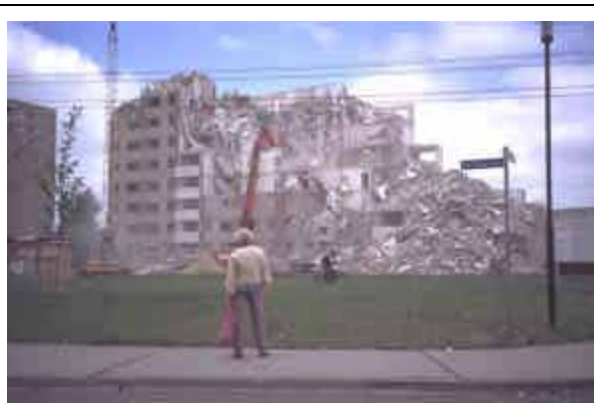
Foto 10: Gebäudeabrisse "Pilotprojekt Rohrweg"
