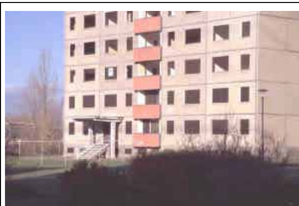
Foto 7: Leer stehende Gebäude
