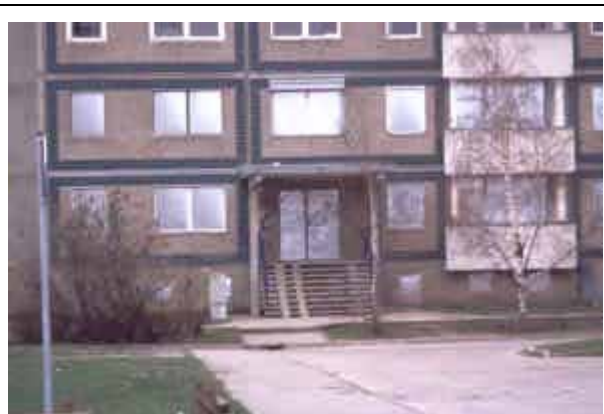
Foto 8: Leer stehende Gebäude
