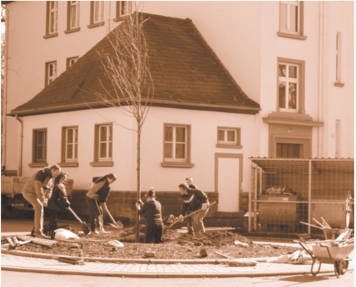
Sanierung und Pflege der Außenanlagen in der "Ringsiedlung", Am Beutelweg und in der Ambrosiusstraße
